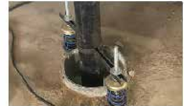
AISLAMIENTO DE TUBERÍAS VERTICALES
