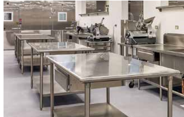
Ventilación comercial en cocinas – Ecuador
